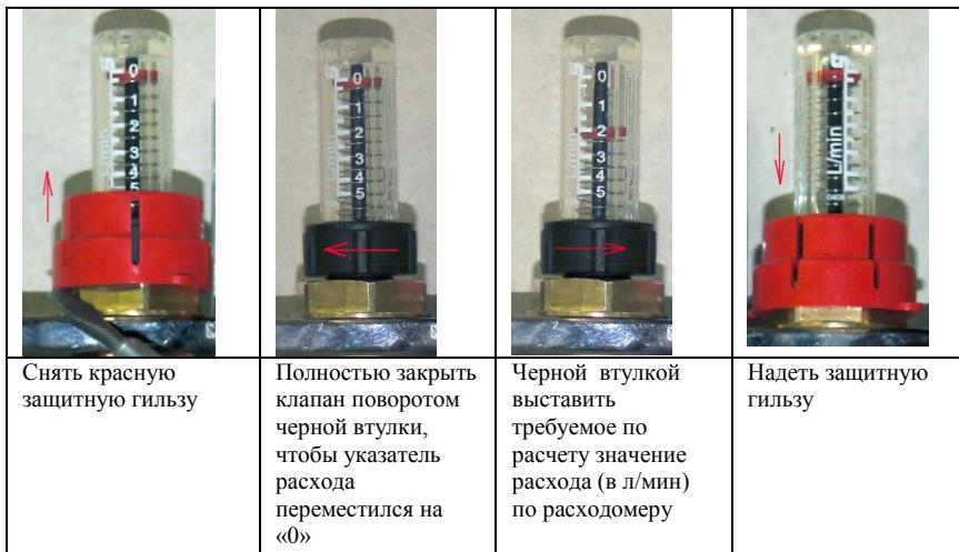
Снять красную защитную гильзу
